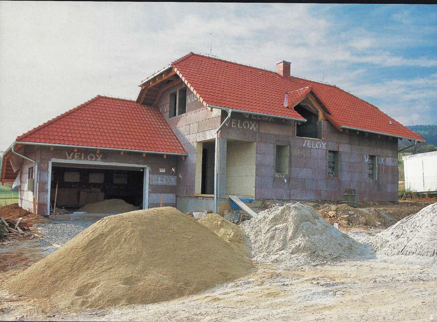
4 Při montáži střešní krytiny jsou osazeny i klempířské prvky, případně vikýře a střešní okna
