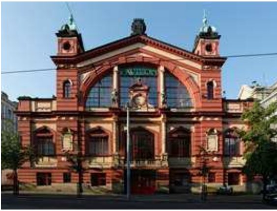
Domov designu. Na místě bývalé tržnice vytvořil Martin Leitgeb galerii designu.
